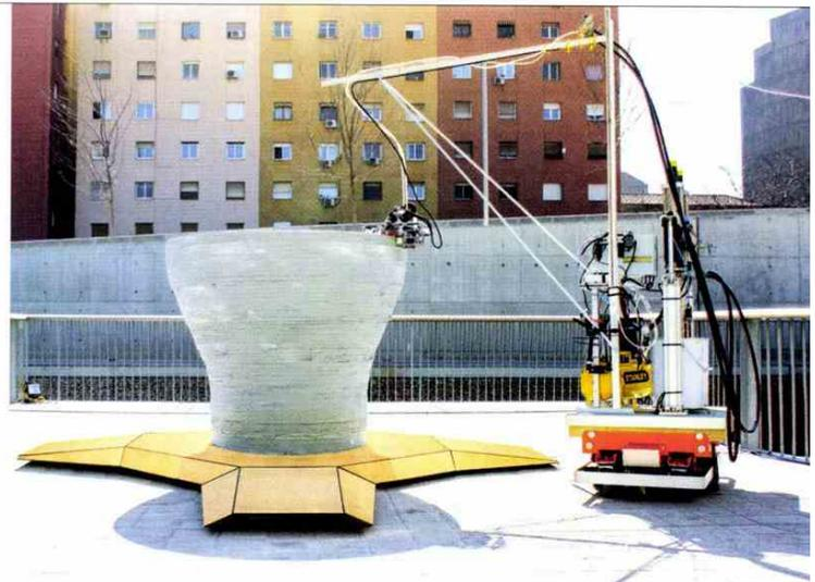
Créés par l'Institut d'architecture avancée de Catalogne, des robots-imprimantes mobiles construisent des maisons en déposant des couches successives de matière.
